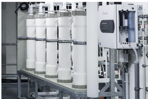
Bild 2: Die Reinstwasser-Membranentgasung zur Sauerstoffentfernung.
