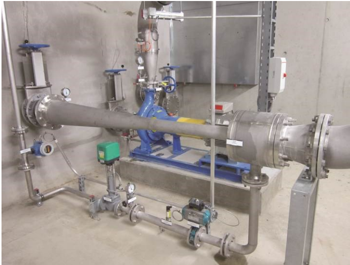
Bild 1: Einmischstrecke für das Ozon in einem großen Projekt der Papierindustrie, in dem HAGER + ELSÄSSER ihr neues AOP-Verfahren umgesetzt haben.
