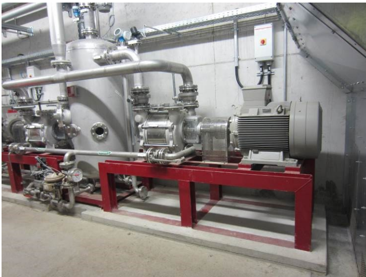
Bild 2: Vakuumpumpen und Ozonerzeugung in einem großen Projekt der Papierindustrie, in dem HAGER + ELSÄSSER ihr neues AOP-Verfahren umgesetzt haben.
